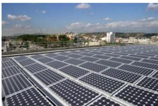
Солнечная батарея (модуль, панель) представляет собой фотоэлектрический генератор, принцип действия которого основан на фотоэлектрическом эффекте. Солнечные батареи соединяют в цепи последовательно и/или параллельно для получения необходимых параметров по току
