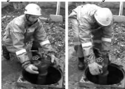
Подача воды от колонки в рукавную линию или в пожарный насос производится по команде **"Воду - дать!"**. При этом пожарный вращает против часовой стрелки до упора (15-16 полуоборотов) маховики (маховик), расположенные на напорных патрубках колонки.
