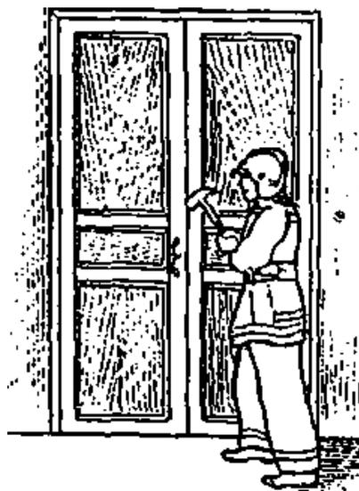
Если она открывается внутрь, то чаще всего щель между створками закрыта планкой, которую надо снять, прежде чем ввести в щель лезвие топора. Чтобы открыть двухстворчатую дверь при помощи топора, надо ввести его лезвие в щель между створками и поворотом топорища раздвинуть их в сторону.
