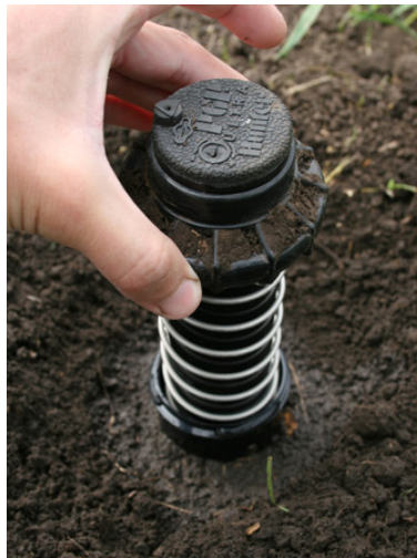
Рис. 109 Демонтаж механизма без выкапывания спринклера целиком
