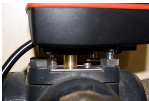
Рис. 51 Крепление привода
