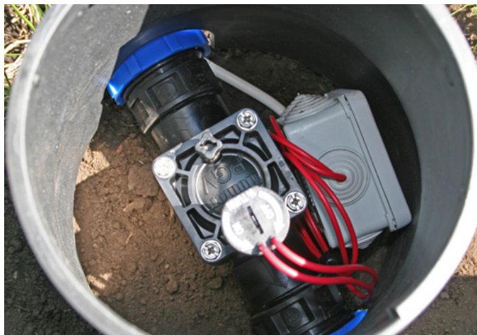
Рис. 101 Установка клапана для автополива
