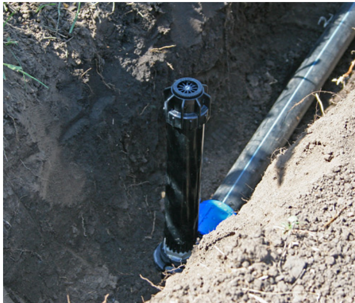
Рис. 107 Установка спрея Hunter PS Ultra
