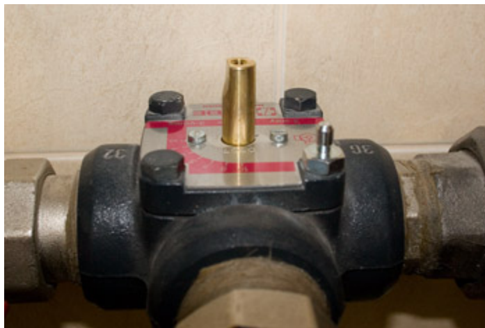
Рис. 50 Вот так предлагает делать фирма ESBE для 3-х ходовых серии 3G
