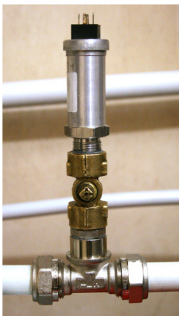
Рис. 105 КРТ-9 смонтирован на металлопластик
