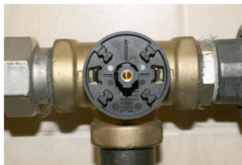
Рис. 51 Крепление привода
