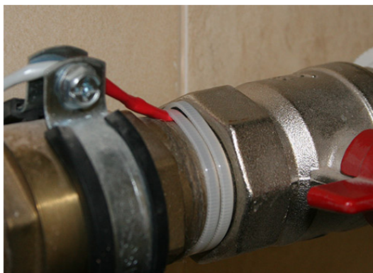
Рис. 54 Фиксация проводов
