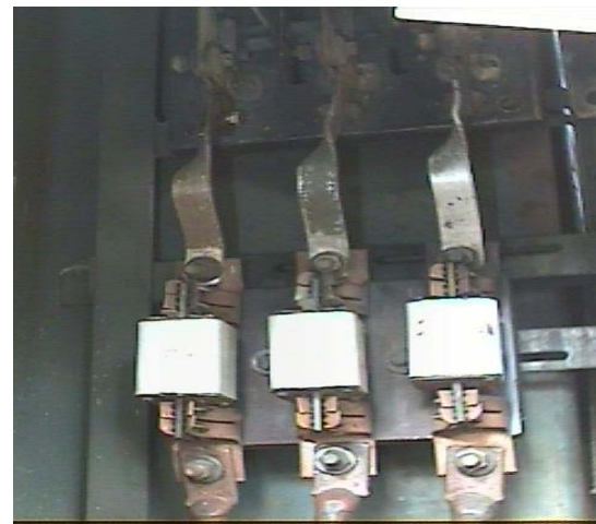
Рис. 11.4. Рубильник электрической печи: а – термограмма; б – фотография
