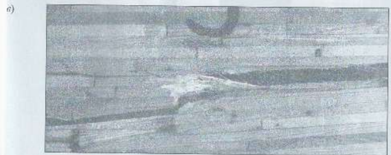
Рис. П1. Место и характер разрушения прямолинейных балок постоянной высоты при испытаниях: а – общий вид разрушения с возникновением семейства трещин; б – трещины, проходящие преимущественно по древесине; в – развитие магистральной трещины с переходом от слоя к слою
