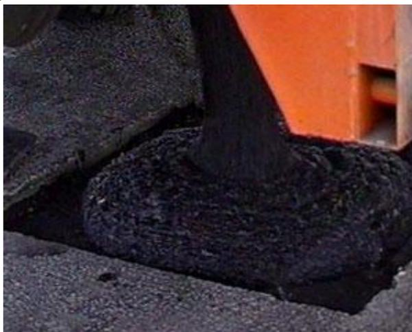
Рис. 3. Выгрузка смеси из термоса-миксера
