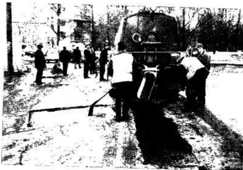
Рис. 4. Ремонт дорожного покрытия литой смесью при помощи термоса-миксера ОРД-1025
